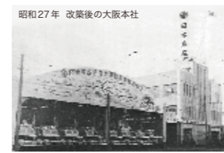
昭和27年 改築後の大阪本社 業界のトップを切って大阪本社を鉄筋建に改築した。
