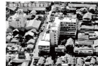
昭和31年 名古屋支店 名古屋支店も広大な敷地に新社屋を建設。
